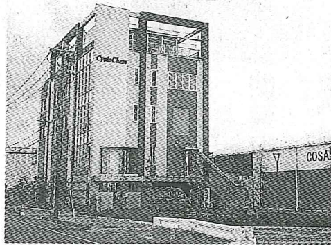
完成した神戸新社屋と研究開発施設
